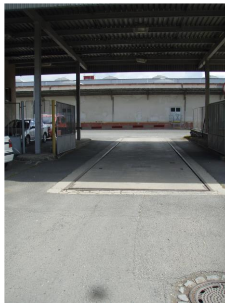
Mostní váha 40 t u hlavního vjezdu
